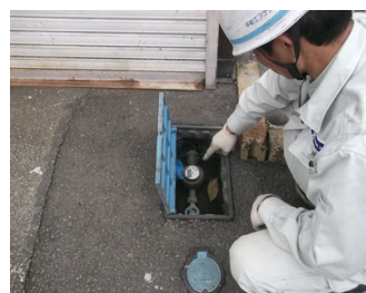
量水器確認 (漏水点検) 漏水無し
