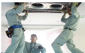
冷媒配管の距離が極端に長すぎる...
